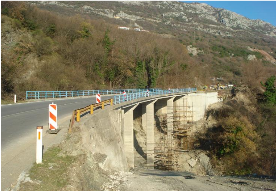
Izgradnja III trake: lokalitet Markovi i
